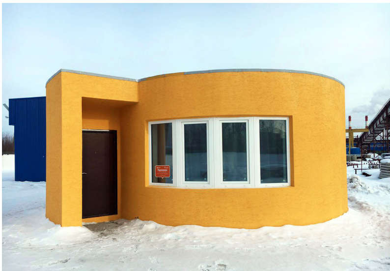
Рис. 1. Здание, построенное с применением 3D-принтера
